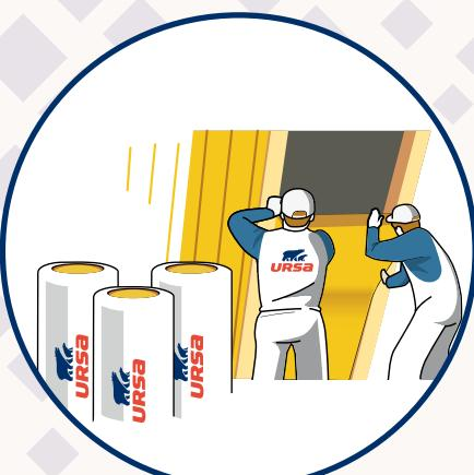
Aplikace minerální izolace URSA SF 35 PLUS mezi krovky. Izolaci mezi krovky postupně vkládáme lehkým vtlačením po obou stranách její výšky, až zaplníme celé krovkové pole. K zajištění izolace v krovkovém poli při aplikaci použijte fixační prvky např. drátkování.
