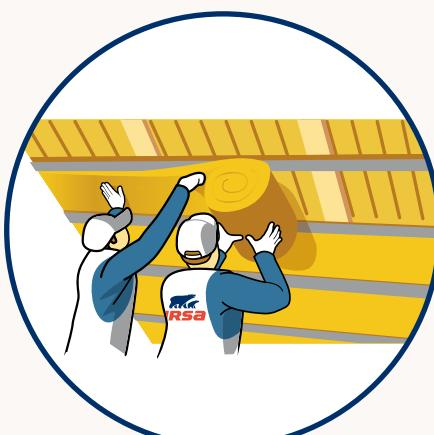
Aplikace minerální izolace URSA SF 35 PLUS do příčného kovového roštu upevněného na krovky, jako druhá tepelně izolační vrstva. Izolaci vkládáme lehkým vtlačením po celé délce roštu. Dbejte stejných zásad jako v předešlém aplikačním kroku.
