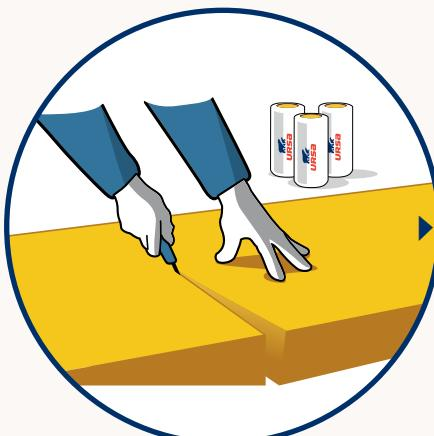
Odřízneme naměřenou část minerální izolace URSA SF 35 PLUS. Řez provádíme podél přítlačné lišty (část OSB desky, kovový profil apod.) speciálním nožem URSA určeným k rezání izolace.
