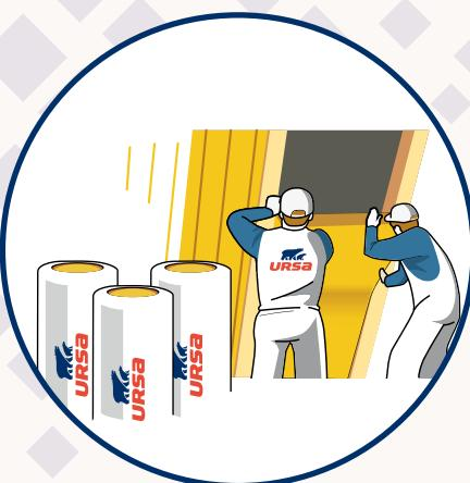
Aplikace minerální izolace URSA DF 32H mezi krovky. Izolaci mezi krovky postupně vkládáme lehkým vtláčením po obou stranách její výšky, až zaplníme celé krovkové pole. K zajištění izolace v krovkovém poli při aplikaci použijte fixační prvky např. drátkování.
